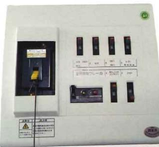
●電気温水器は深夜電力利用のため使用前にブレーカーと電気温水器本体のスイッチを入れて下さい。前日までにこの作業をしてないとお湯が使えません。
